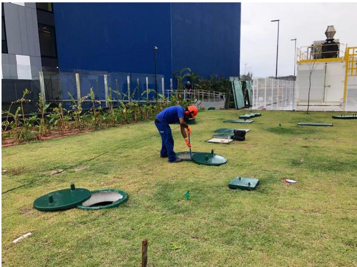
Figura 3. Posicionamento do tanque horizontal enterrado
